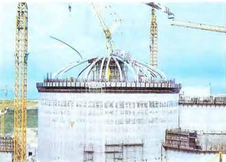
Enceinte de confinement d'un réacteur de 1300 MW
