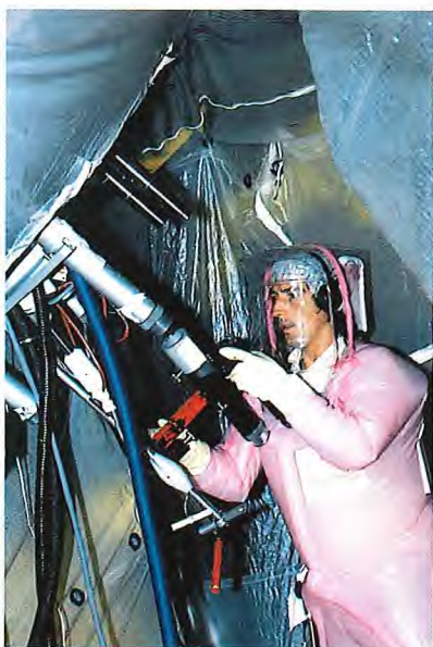
Intervention de maintenance sur tubes de générateurs de vapeur
