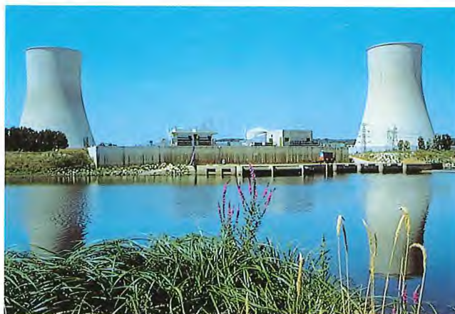
Centrale de Civaux
