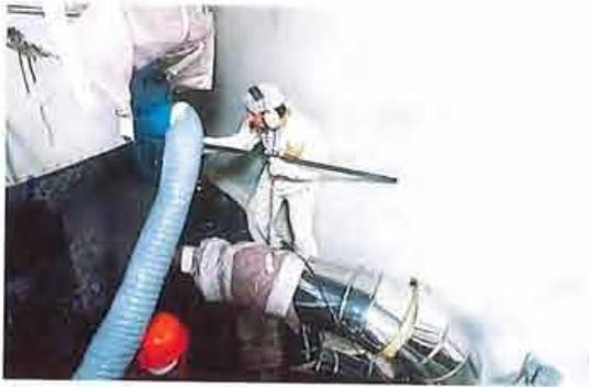
Contrôle d'un tube de générateur de vapeur
