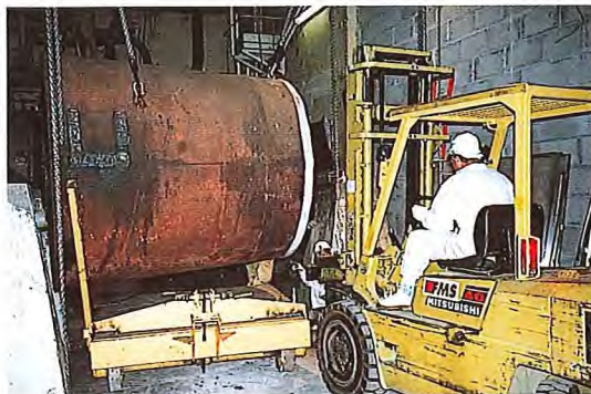
Chinon A3 : chantier de déconstruction des turbo-soufflantes
