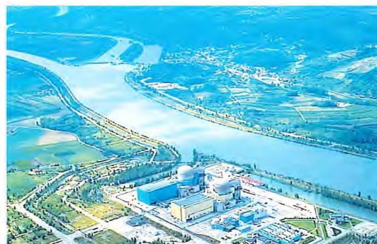
Centrale de Saint-Alban
