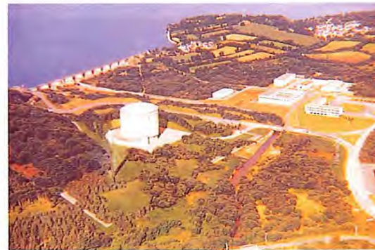
EL4 : le site, tel qu’envisagé, après les opérations de démantèlement autorisées
