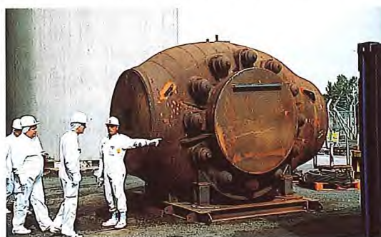
Chinon A3 : sortie d'une turbo-soufflante
