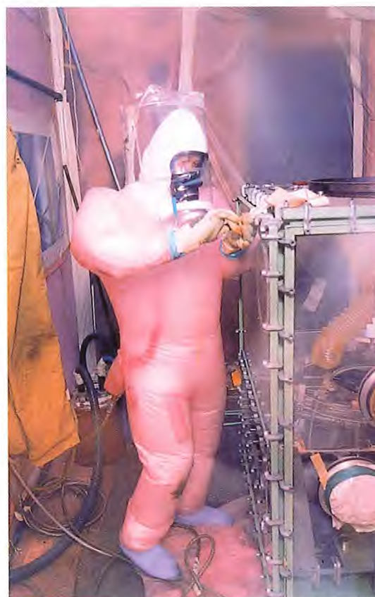
Démantèlement de boîtes à gants dans un laboratoire
