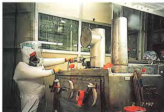
Wak : même boîte à gants, en cours de démantèlement
