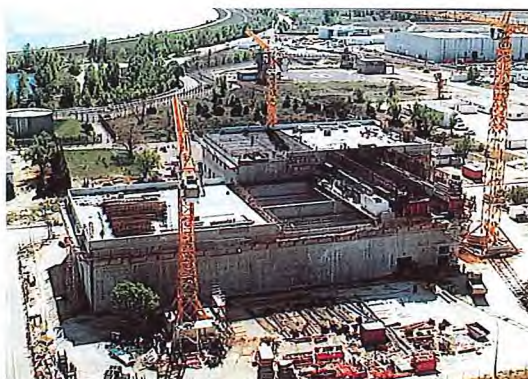
Marcoule : chantier de construction du bâtiment EIP. Ce bâtiment aura pour mission « d'héberger », dans un lieu d'entreposage répondant aux conditions requises de sûreté, les déchets non immédiatement évacuables vers un centre de stockage en surface
