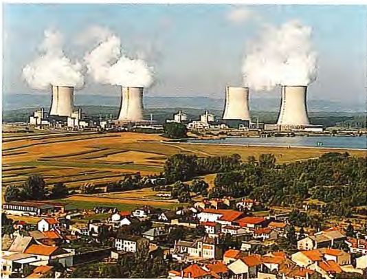
Centrale de Cattenom
