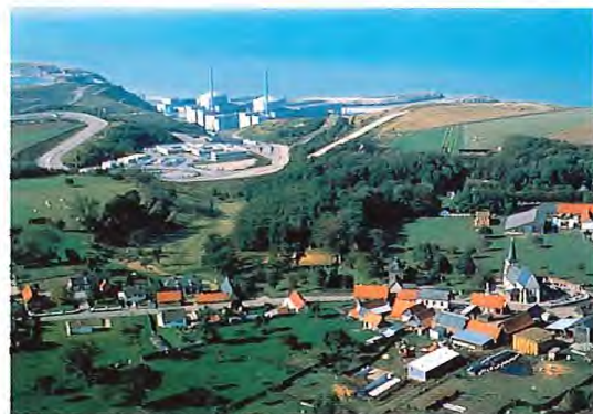
Centrale de Penly
