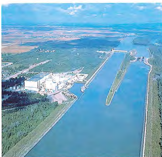
Centrale de Fessenheim
