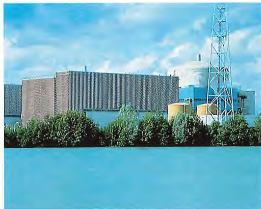
Centrale de Nogent-sur-Seine
