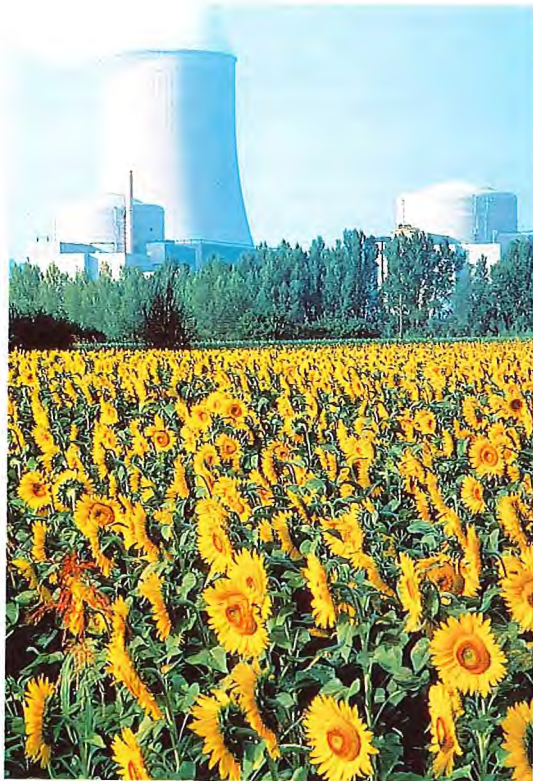
Centrale de Golfech
