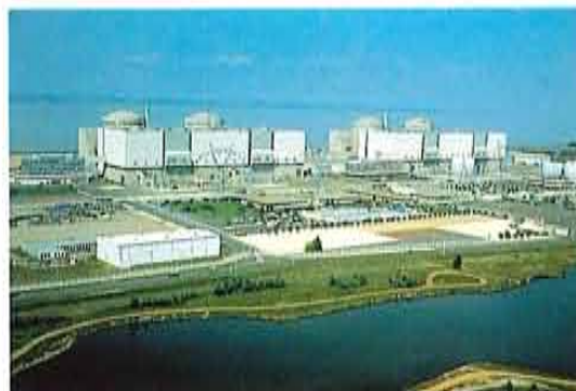
Centrale du Blayais.
