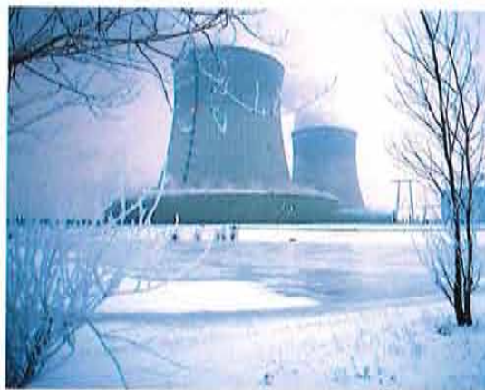
La centrale de Saint-Laurent en janvier 1987
