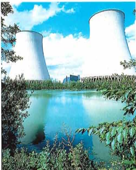
Centrale de Nogent-sur-Seine.
