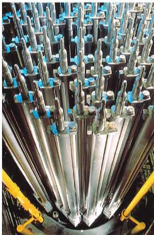
Chooz : mécanisme des barres de commande.
