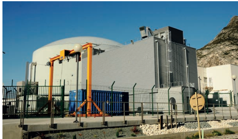
RHF - Bunker du poste de conduite de secours (PCS 3) mis en place à la suite des ECS post-Fukushima - Octobre 2013
