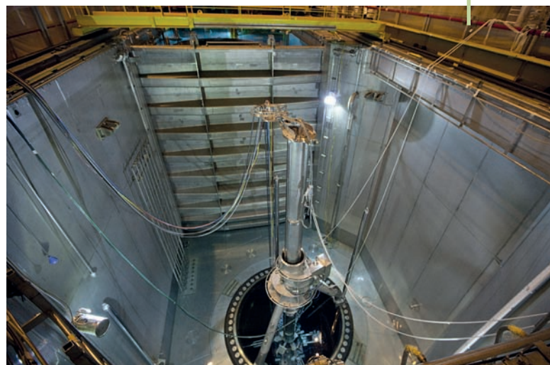
Inspection de la cuve du réacteur 5 par le robot MIS (machine d'inspection en service), à la centrale nucléaire du Bugey – Août 2011
