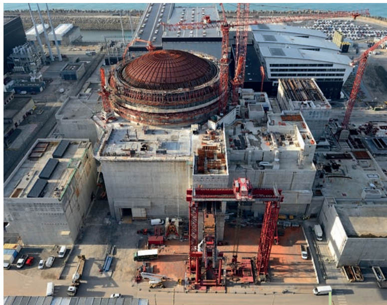
Chantier de l'EPR de Flamanville: on aperçoit le bâtiment réacteur, le bâtiment des auxiliaires nucléaires, le bâtiment combustible et les bâtiments des diesels – Décembre 2013
