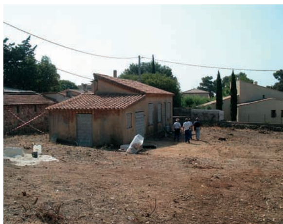
Site de la propriété Danne à Bandol
