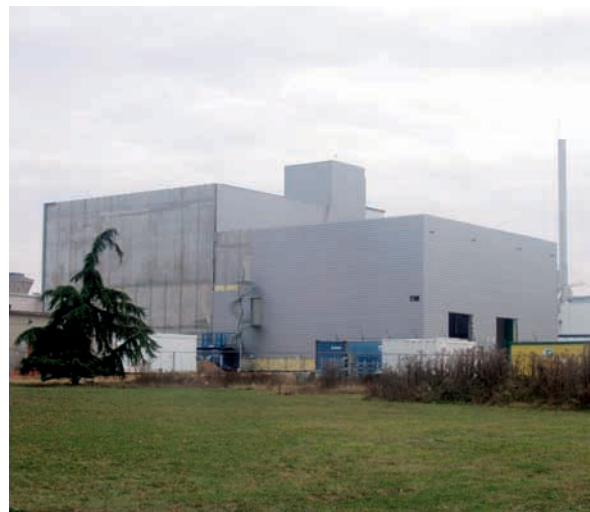
Bâtiment de l'extension STELLA de l'INB 35 à Saclay
