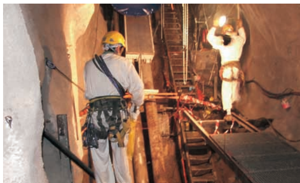
Démantèlement du carneau de ventilation à Chooz
