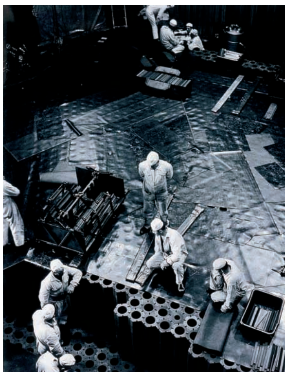
Assemblage de graphite dans un réacteur
