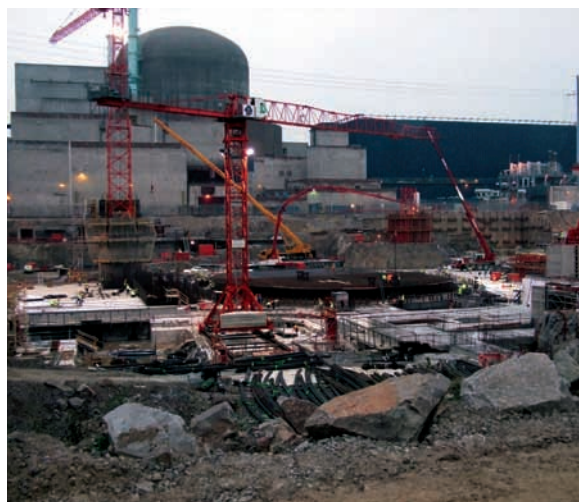
Chantier de Flamanville 3
