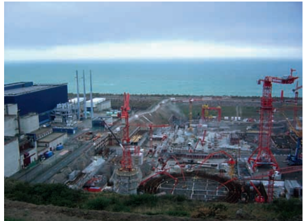
Bétonnage du radier de l'îlot nucléaire
