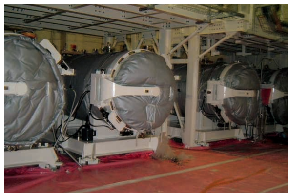
Nouveaux autoclaves de FBFC à Romans-sur-Isère
