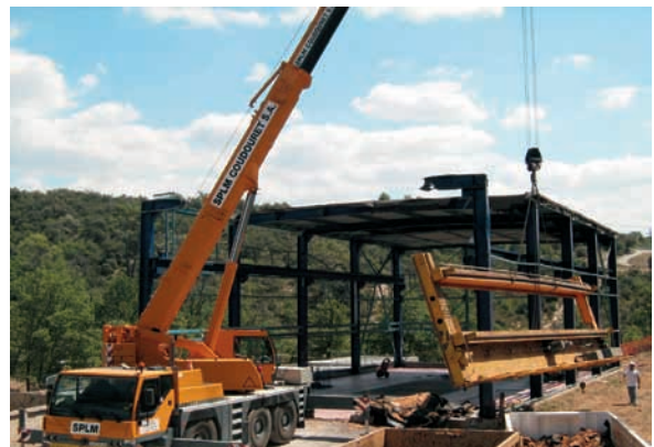
Dépose du pont roulant du réacteur Harmonie à Cadarache
