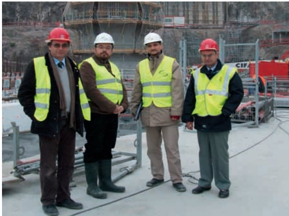
Une équipe d'inspection sur le chantier de Flamanville 3
