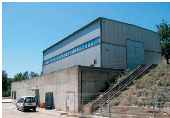
Réacteur Harmonie à Cadarache avant démolition
