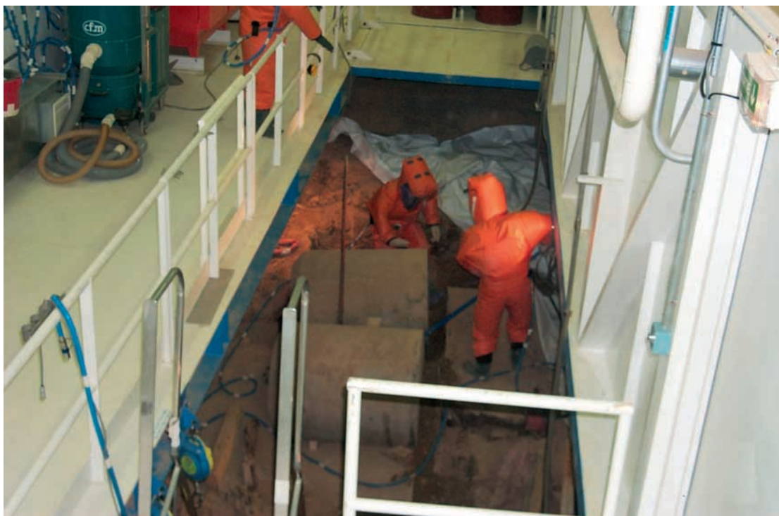
Chantier de reprise des tranchées de l'INB 56 à Cadarache
