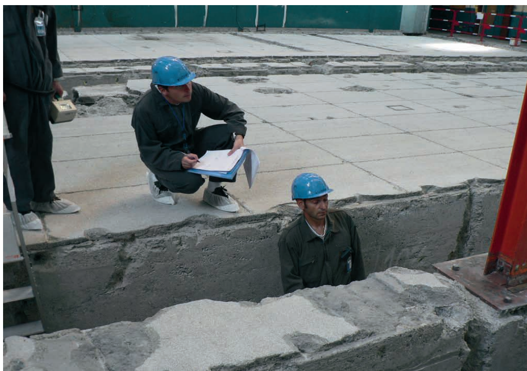
Inspection de l'ASN pour le déclassé du bâtiment C de SICN à Veurey-Voroize
