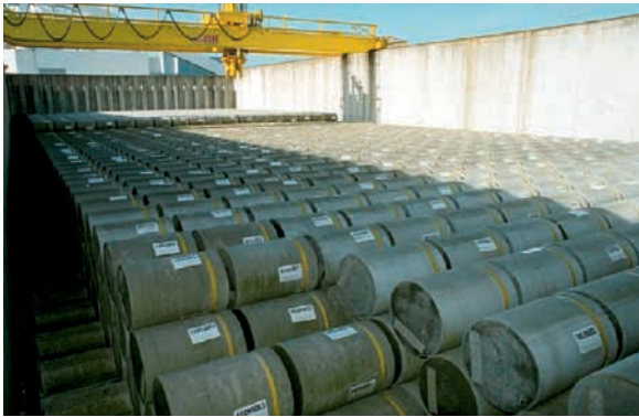
Entreposage des fûts de déchets dans l'atelier ADT – AREVA NC à La Hague
