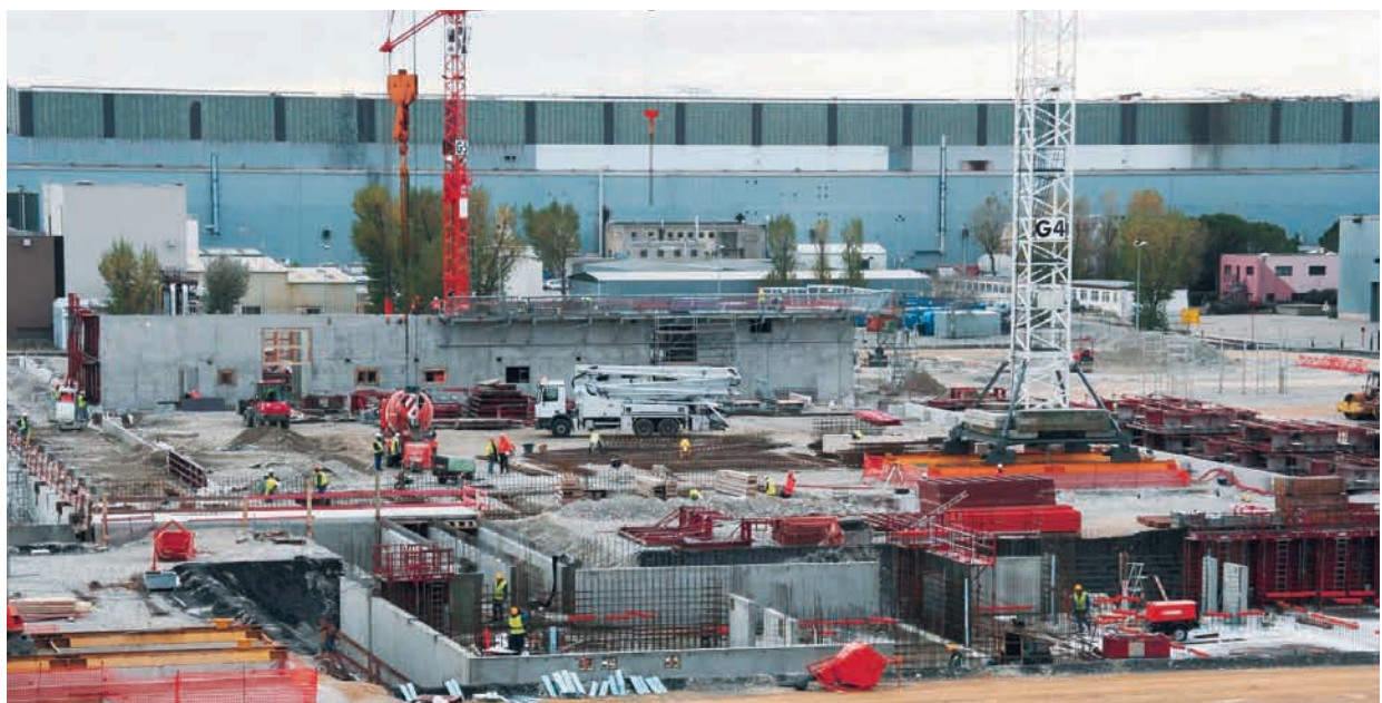
Chantier de construction de l'usine Georges Besse II
