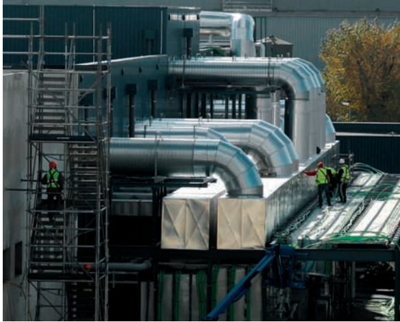
Chantier de construction de Georges Besse II à Tricastin
