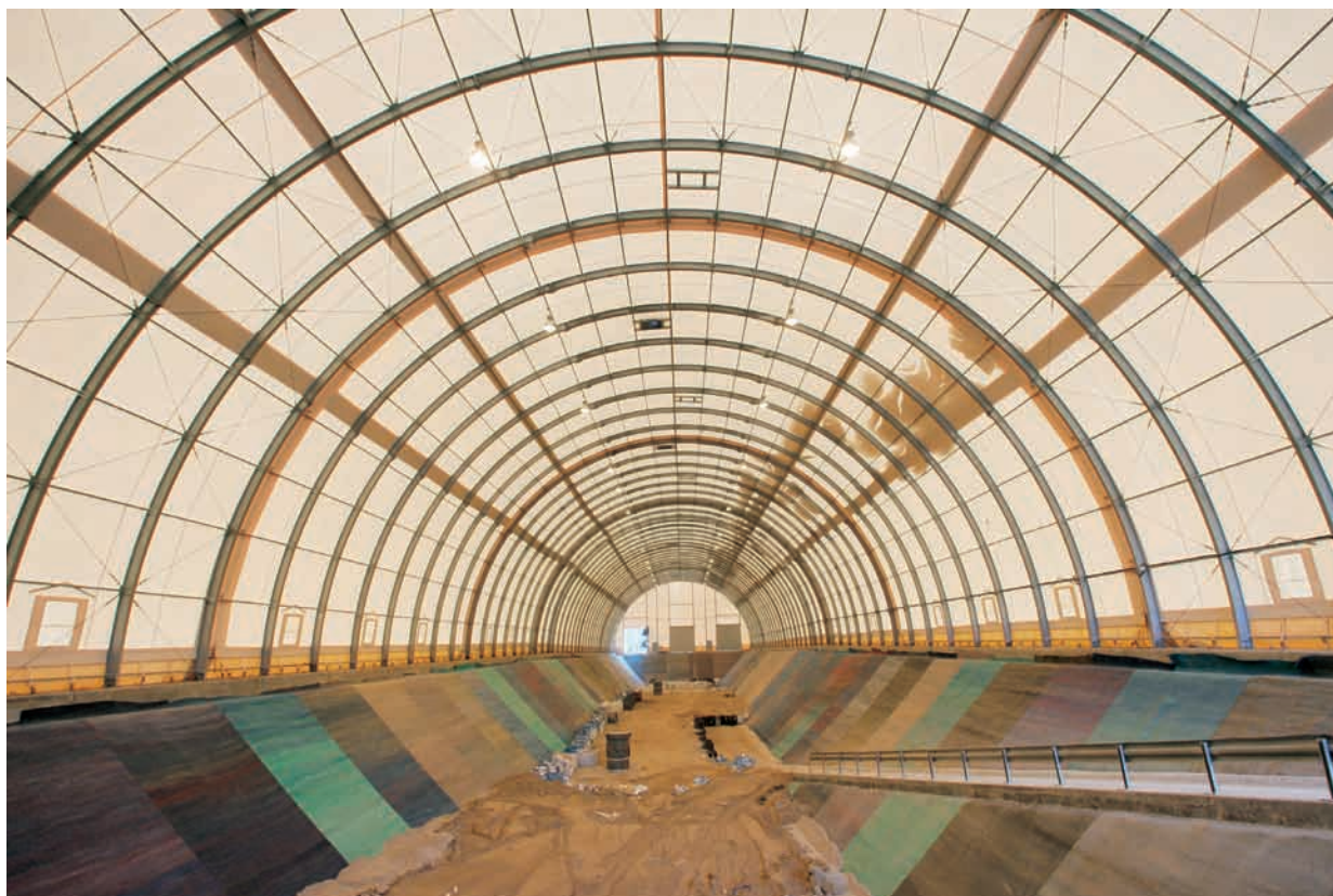
Cellule au centre de stockage TFA de Morvilliers
