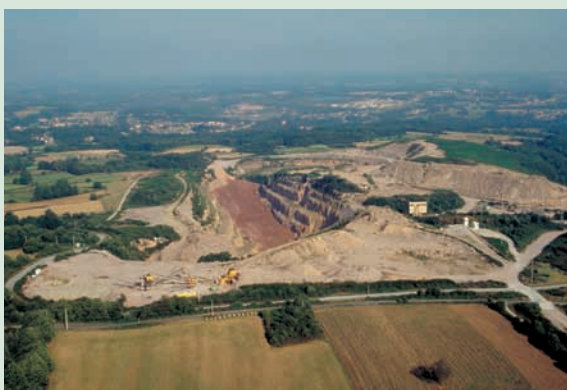
L'ancien site minier de Bellezane (Haute-Vienne) avant son réaménagement
