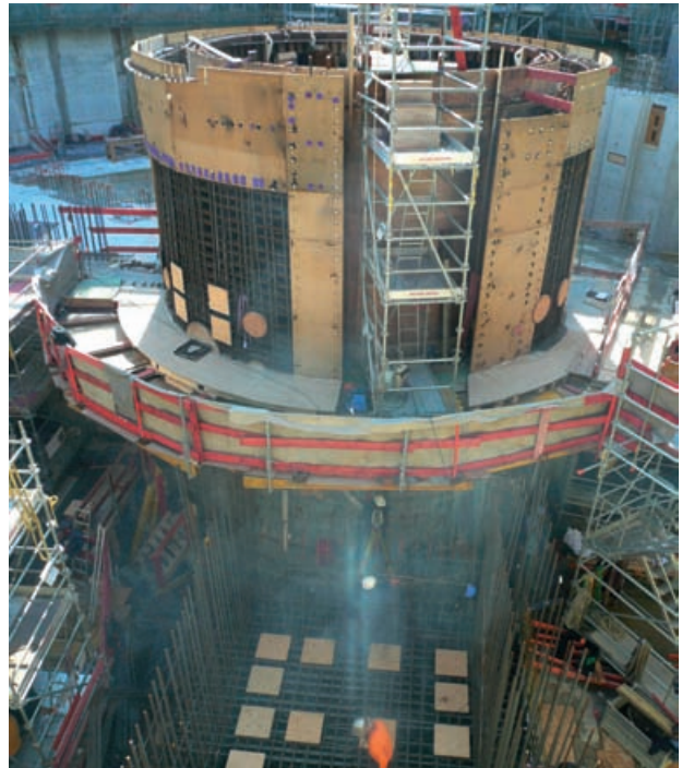
Vue du bâtiment réacteur et de la piscine du RJH
