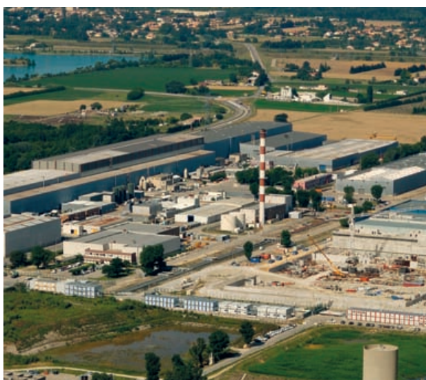
Vue de l'usine de SOCATRI sur le site du Tricastin
