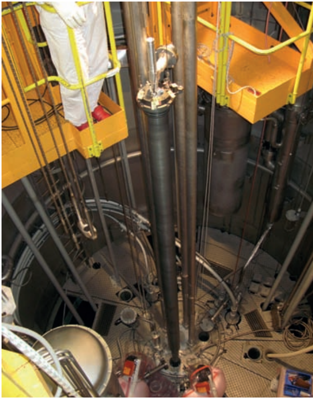
Opération de remplacement des sources froides d'ORPHÉE
