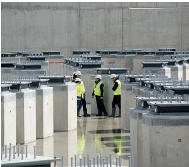
Inspection de l'ASN sur le chantier ITER : construction des appuis parasismiques du complexe Tokamak – Avril 2012
