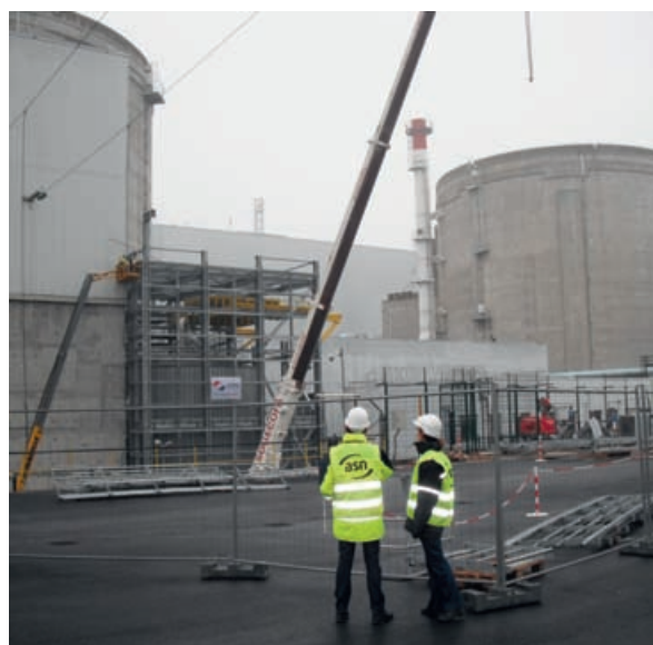
Inspection de chantier de l'ASN sur le site de la centrale nucléaire de Fessenheim – Novembre 2012
