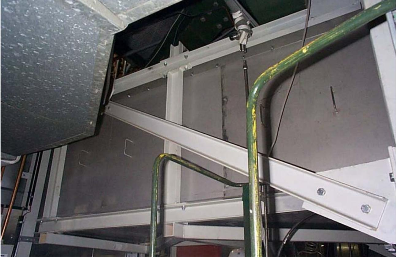
Mise en place d'un cloisonnement autour des zones sodium pour améliorer la protection vis-à-vis des feux sodium
