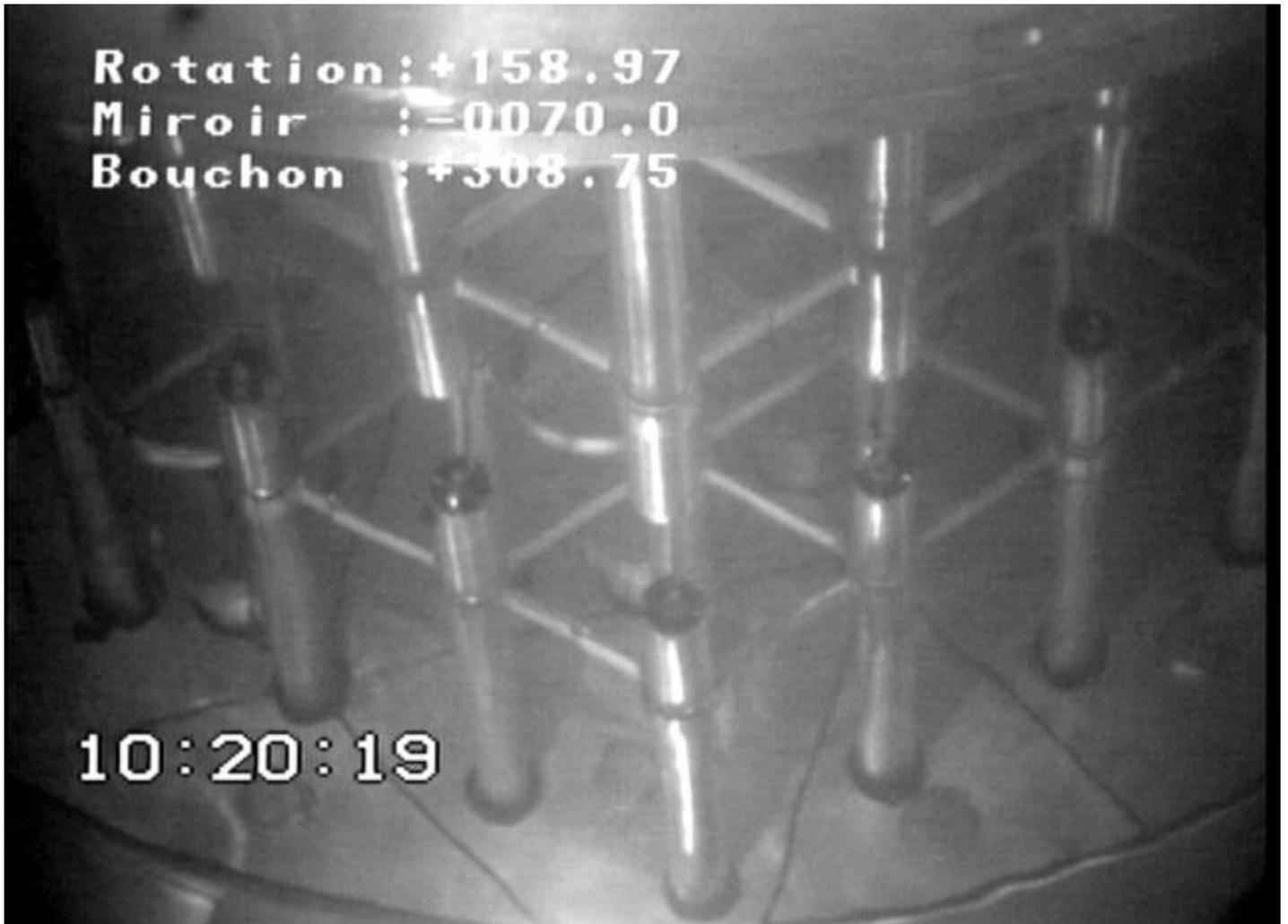
Inspection de la grille inférieure du bouchon couvercle cœur par reflet dans le sodium primaire
