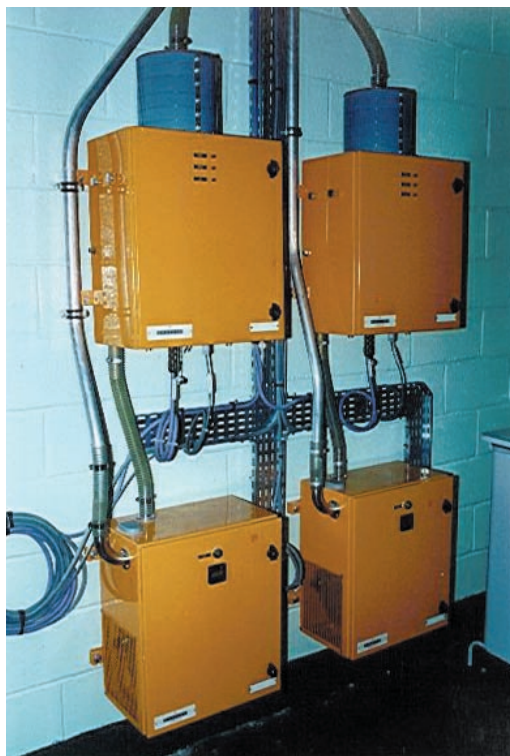
Chaînes de radioprotection associées à un tableau de contrôle radiologique – Un défaut de maintenance peut être à l'origine de défaillances de mode commun
