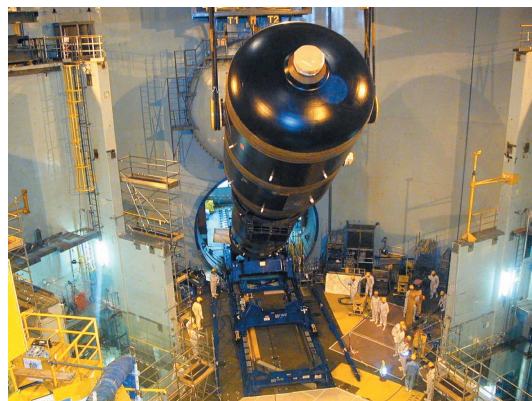
Remplacement de générateurs de vapeur Contrôle US joint final GV
