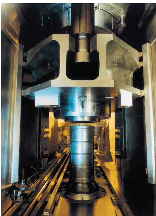
Conditionnement des déchets de structure : la presse de l'atelier ACC
