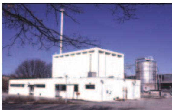
Le réacteur expérimental CABRI permet de simuler avec une bonne représentativité, notamment thermohydraulique et neutronique, les phases caractéristiques d'un accident de dimensionnement correspondant à l'insertion brutale de réactivité et donc de puissance dans un crayon combustible
