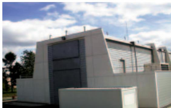
Le laboratoire LECl permet l'étude du comportement mécanique sous irradiation des matériaux de structure et des matériaux assurant le confinement des combustibles. Les expériences portent sur des échantillons de petites tailles, ce qui permet de limiter l'inventaire radiologique de Saclay.
