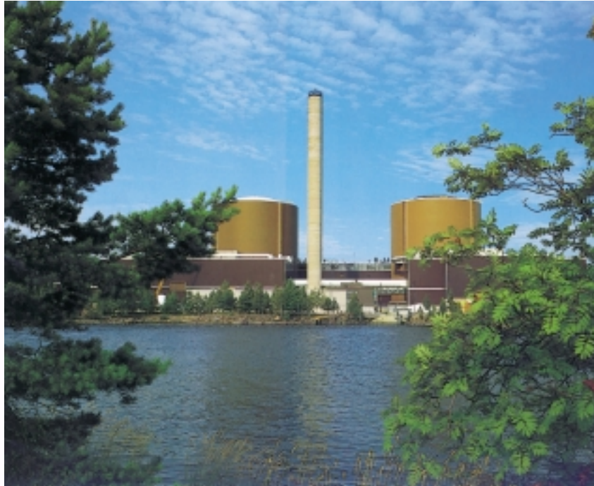
Centrale de Loviisa (Finlande)
