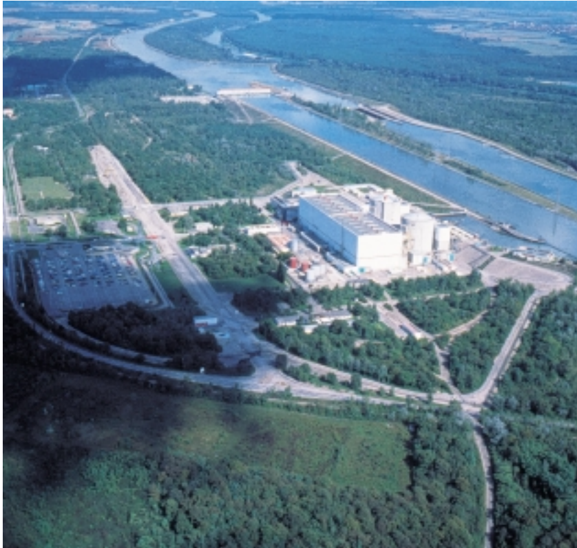
Centrale de Fessenheim
