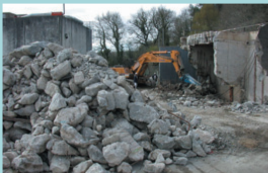
Les opérations de démolition
