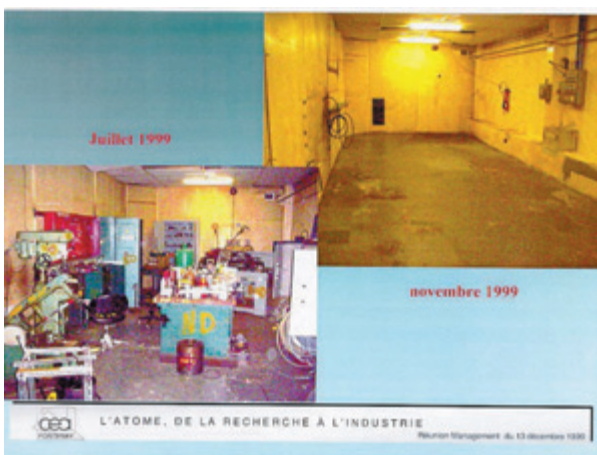
Cellule du laboratoire de chimie du plutonium (LCPu) au CEA de Fontenay aux Roses
