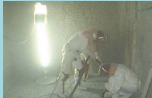
Les opérations d'assainissement
