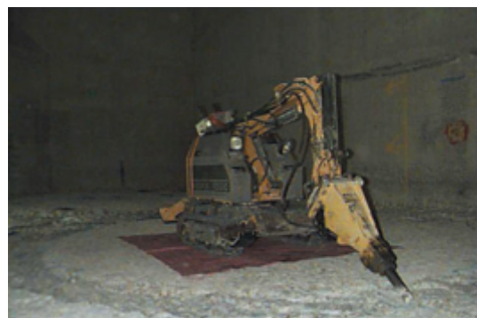
Engin utilisé pour les opérations d'assainissement
