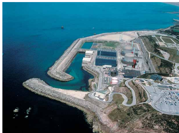
Vue aérienne du site de Flamanville
