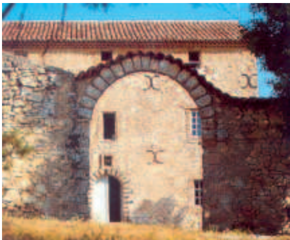
Ferme du service de radioprotection contre les rayonnements (SPR) du groupe environnement du CEA
