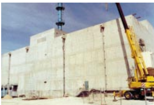
Cette vue de l'atelier R4 en fin de construction révèle la structure massive en béton armé, quasiment dépourvue d'ouvertures sur l'extérieur, d'un atelier nucléaire de l'Etablissement du site de La Hague
