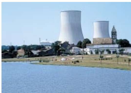
Centrale de Civaux
