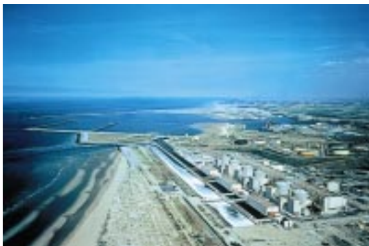
Centrale de Gravelines
