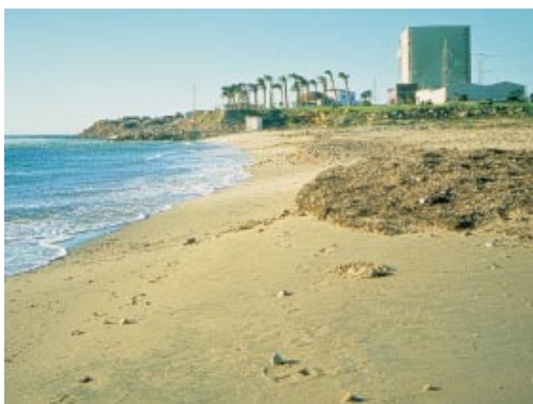
Centrale de Vandellos (Espagne)
