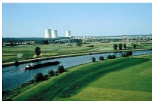
Centrale de Cattenom
