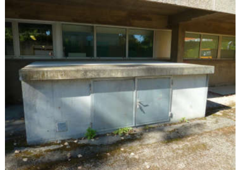
Entrée local cuves de décroissance
