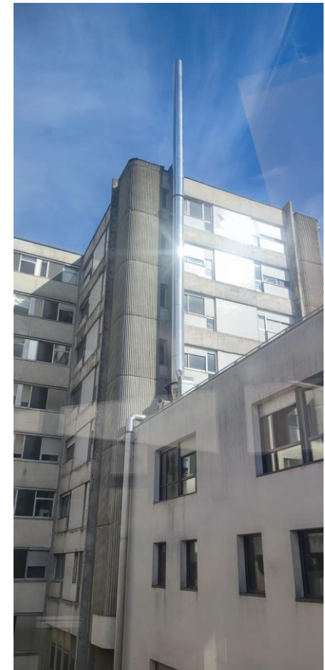
Cheminée d'évacuation des effluents gazeux de Médecine Nucléaire
