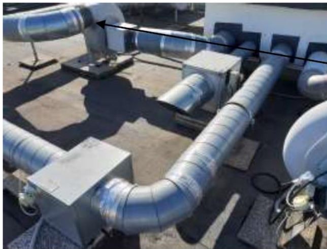
Gainex d'extraction en terrasse
