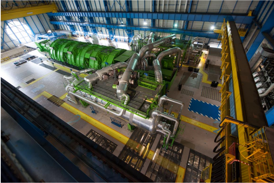
Figure 3 : Circuit vapeur et groupe turboalternateur en salle des machines
