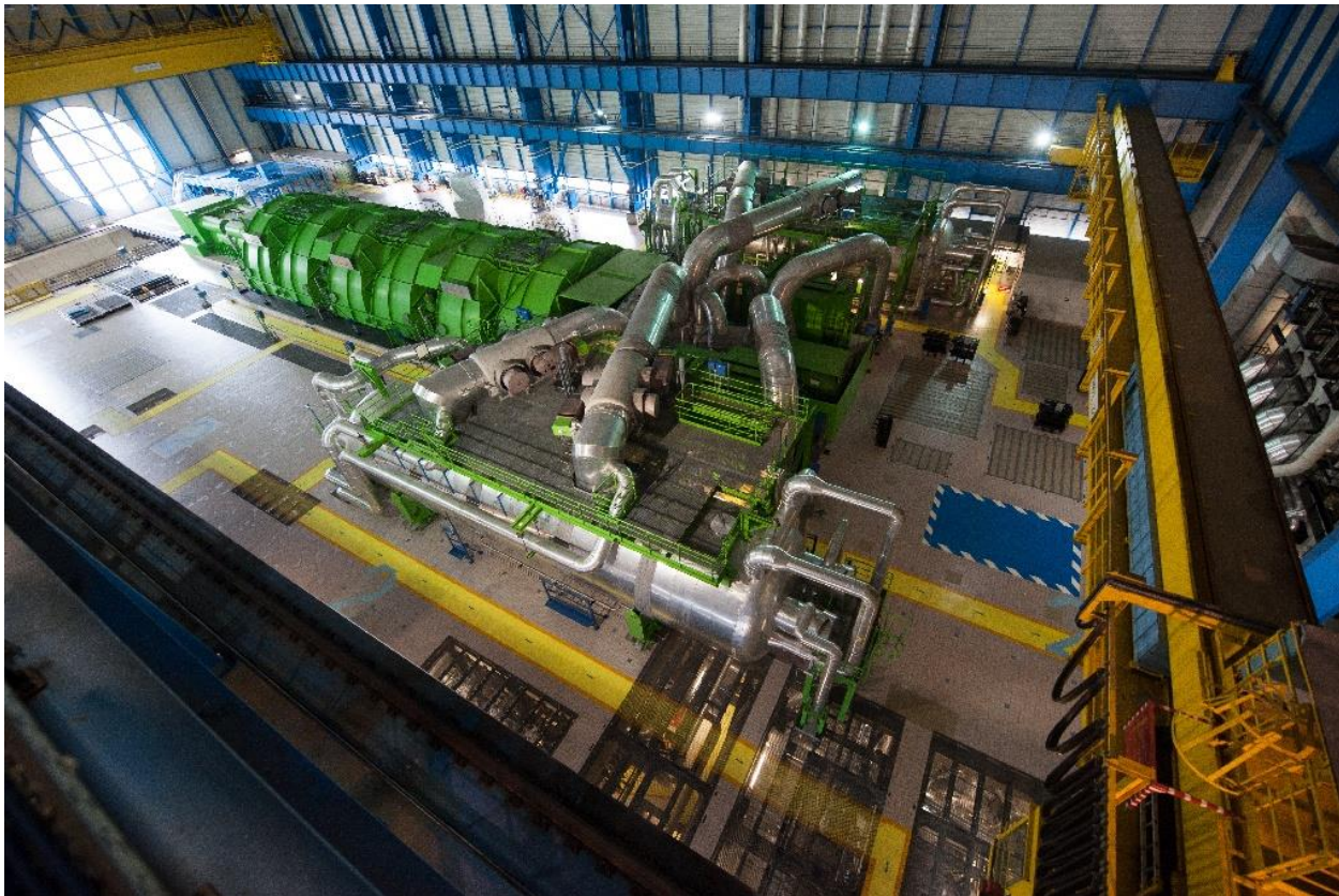
Figure 7 : Salle des machines du CNPE de Civaux, groupe turboalternateur
