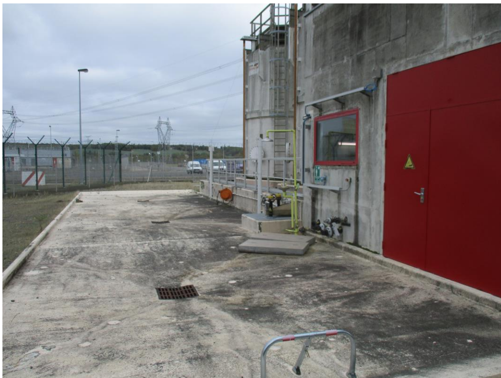
Figure 5 : Une aire de dépotage du CTE à Civaux © EDF
