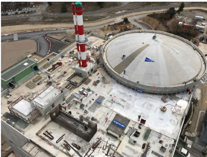
Figure 21 – Etat de construction en mai 2017
