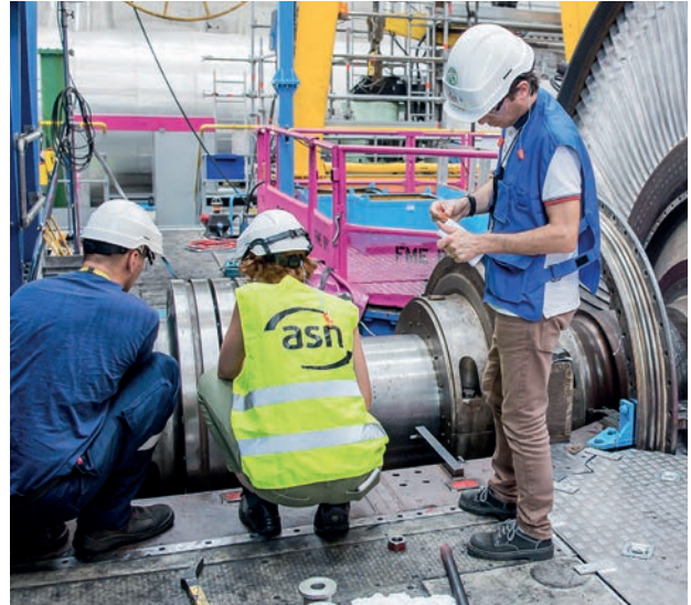
Inspection de l'ASN à la centrale nucléaire du Blayais – Turbine en maintenance
