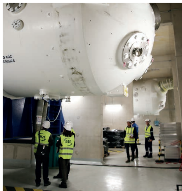
Inspection de revue de l'ASN à la centrale nucléaire de Gravelines – Générateur de vapeur – Mai 2018
