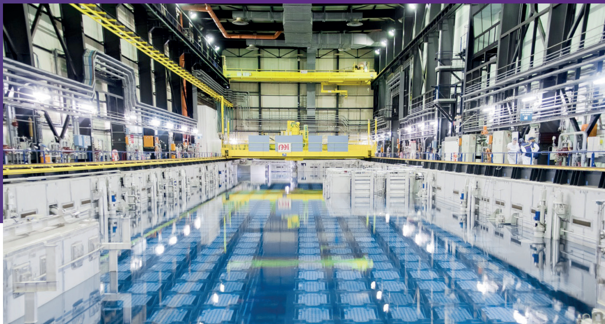
Piscine d'entreposage de combustibles de La Hague
