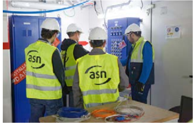
Inspection de l'ASN – Bâtiment réacteur : préparation à l'épreuve enceinte – mars 2018
