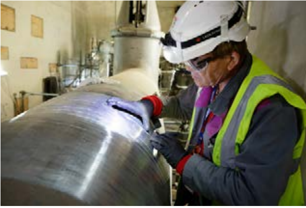
Contrôle des soudures du circuit primaire principal – EPR Flamanville
