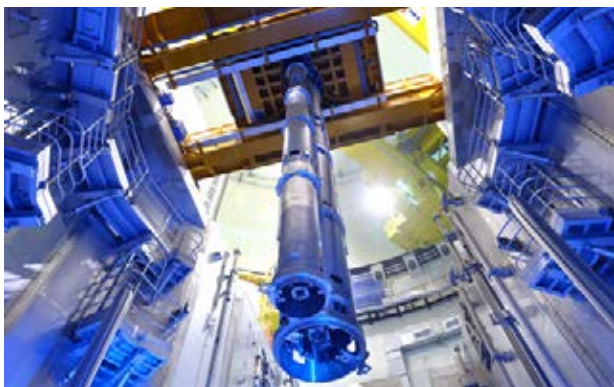
Essais « en air » de la machine de chargement du combustible
