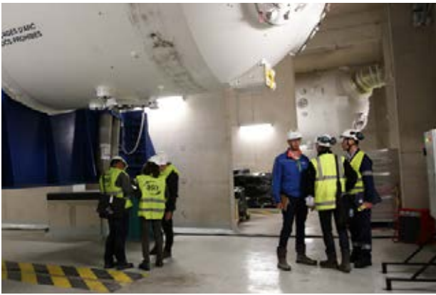
Inspection de revue de l'ASN à la centrale nucléaire de Gravelines - mai 2018
