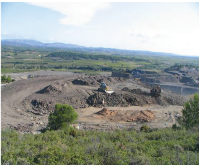
Figure 46 : Remodelage de déchets et mise en œuvre d'une couverture sur un ancien centre d'enfouissement technique
