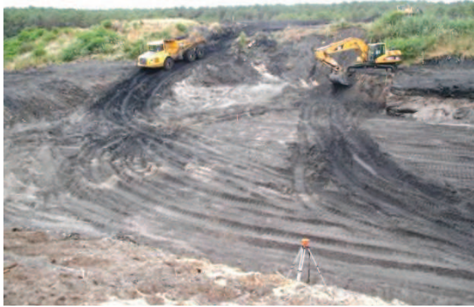
Figure 47 : Excavations de boues de procédé pour création d'une alvéole de stockage (industrie papetière)
