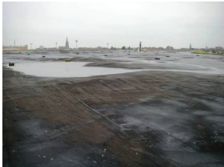
Figure 50 : Ouverture du terril de Wattrelos, géomembrane bitumineuse
