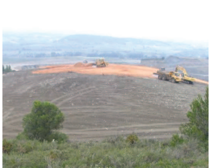
Figure 46 : Remodelage de déchets et mise en œuvre d'une couverture sur un ancien centre d'enfouissement technique
