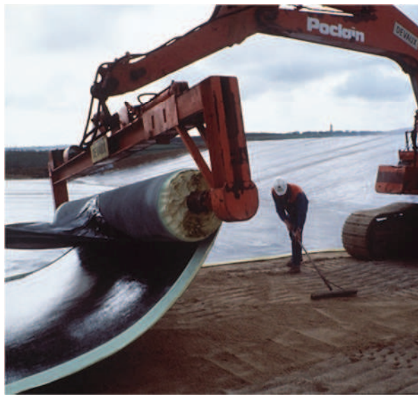
Figure 49 : Pose de la membrane bitumineuse sur le centre de stockage de la Manche en 1996
