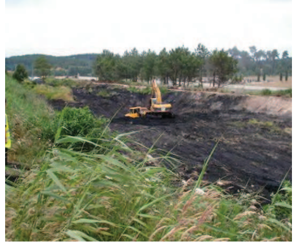
Figure 47 : Excavations de boues de procédé pour création d'une alvéole de stockage (industrie papetière)
