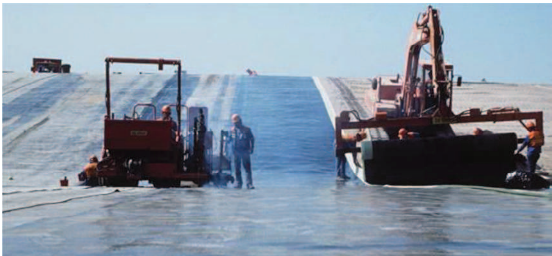
Figure 44 : Pose d'une bande de membrane bitumineuse en parallèle à son soudage
