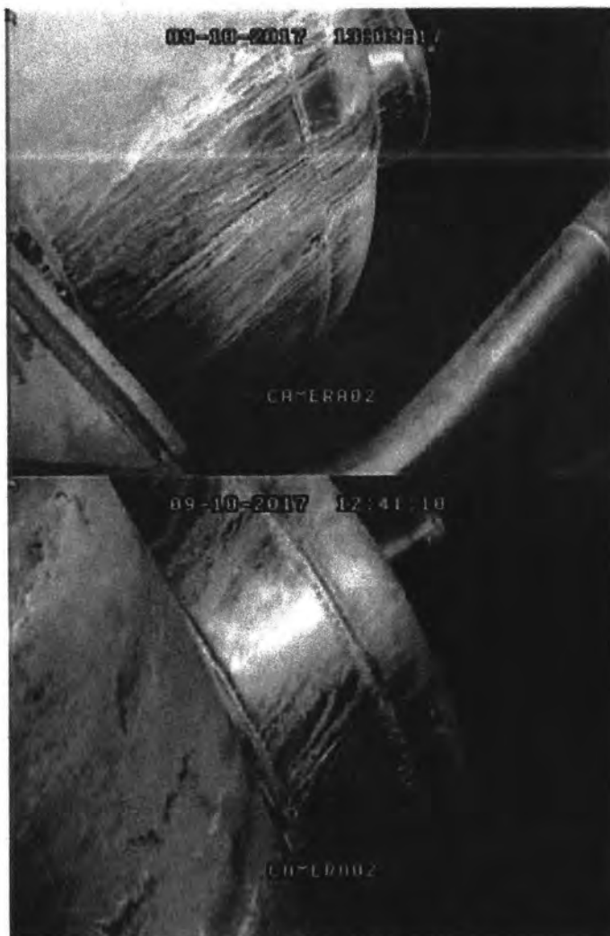
Figure 12 – Photos du dôme du bouilleur
