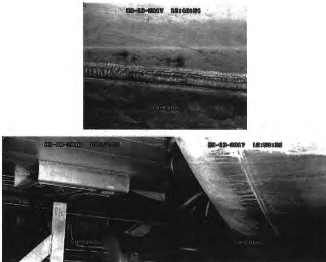
Figure 13 – Photos de la partie supérieure de la virole au-dessus de la zone de marnage
