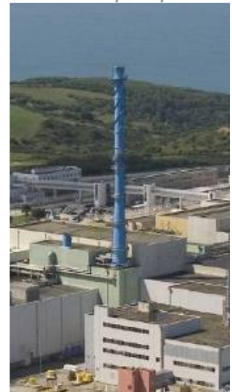
Cheminée principale UP3
