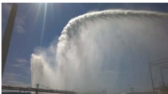
Essai des canons à eau installés pour l'abattage de l'HF
