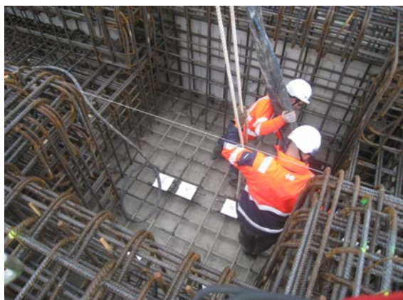
Opération de coulage des premiers bétons de l'atelier EM3
