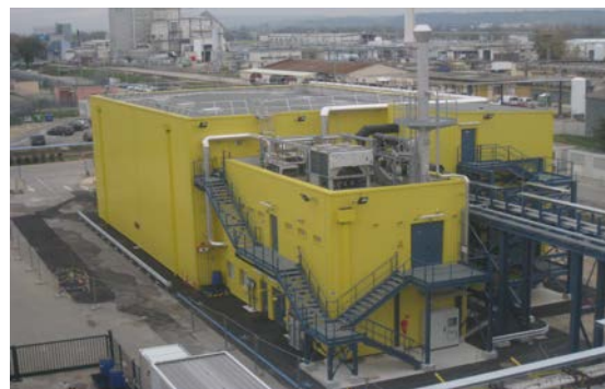
Nouveau bâtiment d'entreposage de l'UF 6
