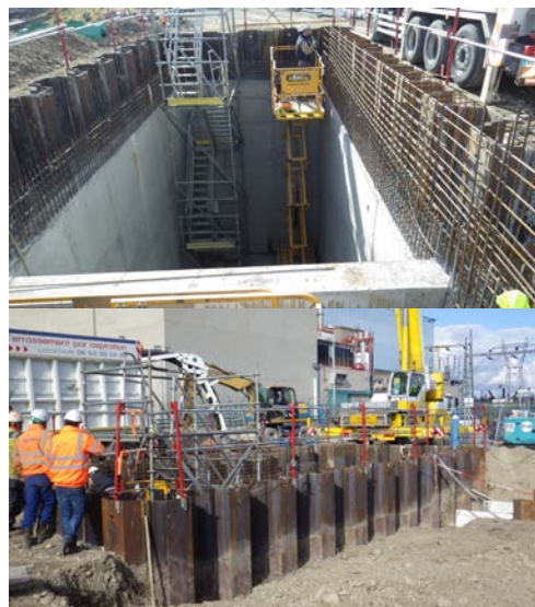
Construction des bassins de confinement sur les réseaux d'eau pluviale du site de Saint-Alban Saint-Maurice
