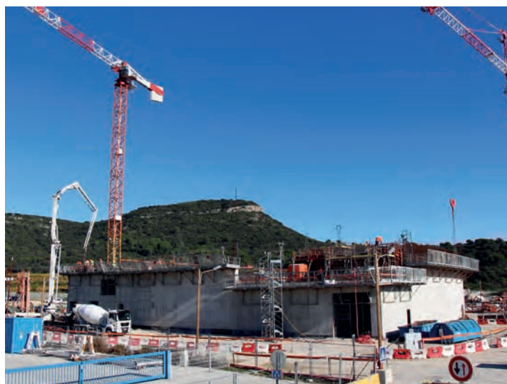
Chantier de Diadem, novembre 2016.
