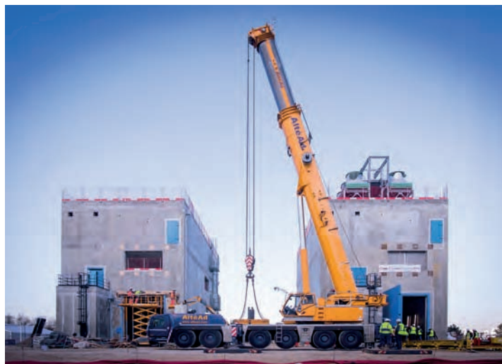
Mise en place d'un diesel d'ultime secours à la centrale nucléaire de Saint-Laurent-des-Eaux, novembre 2016.
