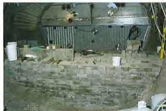
Scellement en argile gonflante en cours de construction. Essai TSX dans l'Underground Research Laboratory au Canada
