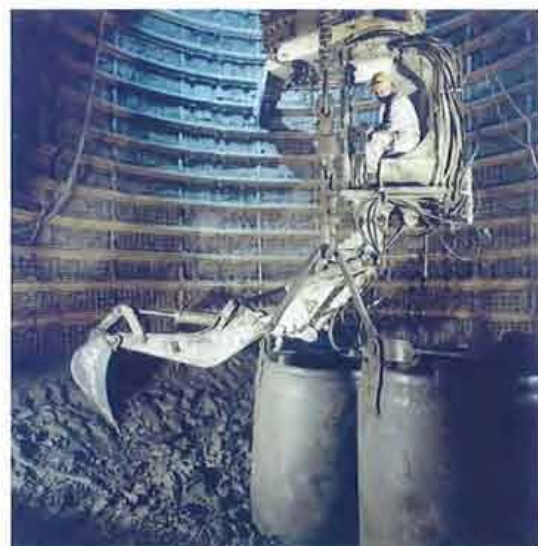
Creusement du puits d'accès Praclay (Belgique)
