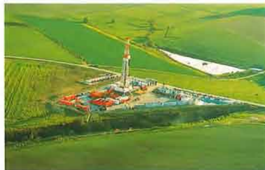
Forage sur le site Meuse/Haute Marne
