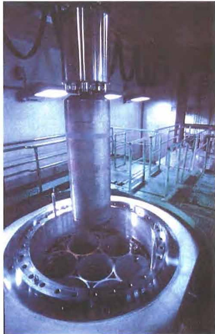
Déchargement de conteneurs de déchets vitrifiés hors d'un emballage de transport
