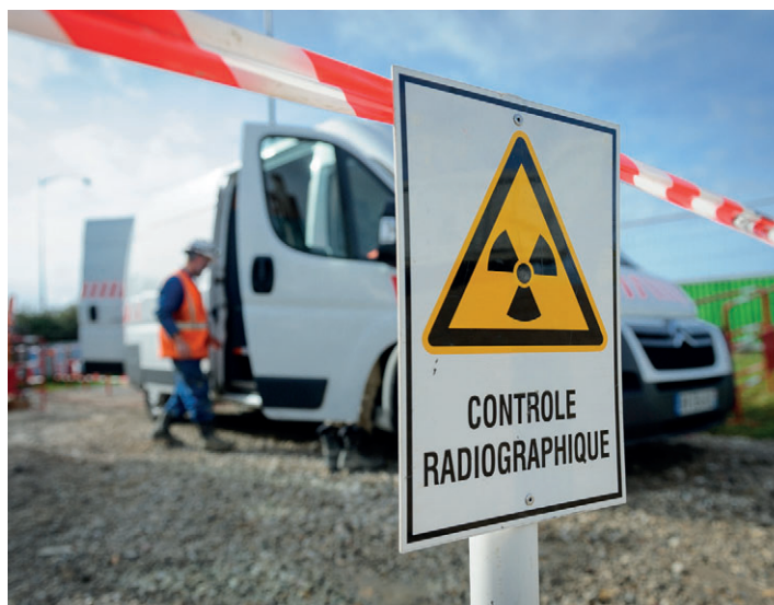
Chantier d'ouvrage de transport de gaz naturel. Balisage pour tir radiographique.
