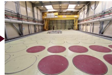
Entreposage de déchets MA-VL irradiants dans Cedra (Cadarache)
