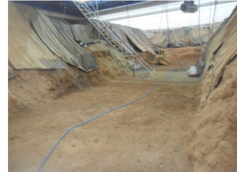
Evacuation des déchets de la tranchée T2 - INB 56 - Cadarache
