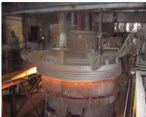
Figure 22 - Four Electrique à Arc
