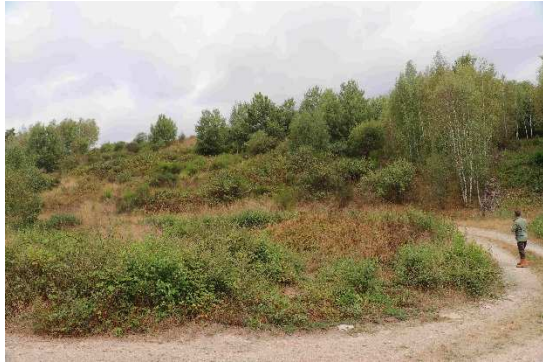
Figure 1 – Ouvrage ceinturant le stockage de résidus miniers sur le site Le Brugeaud
