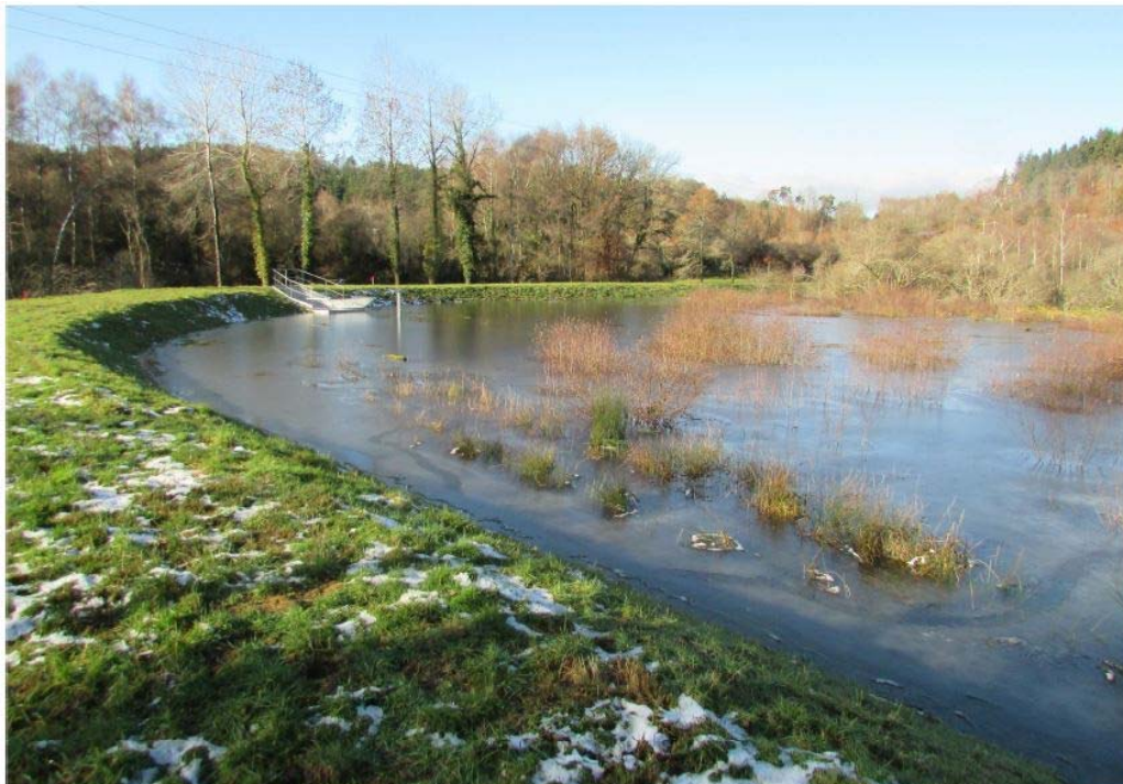
Figure 14 : La tourbière des Sagnes (87) après aménagement et mise en eau
