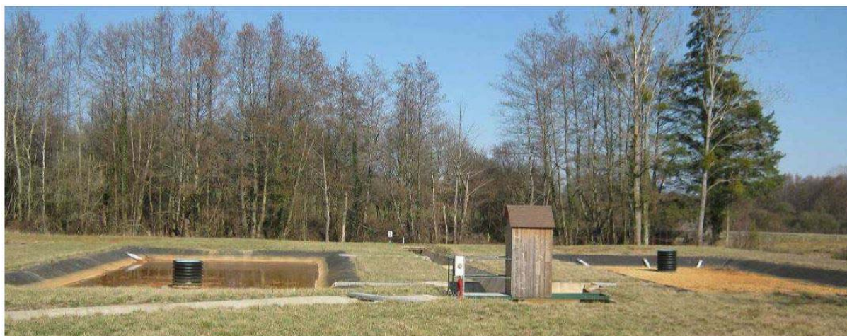
Figure 5 : Station de traitement des eaux par drains calcaires à Cérilly (03) (Gibeaux et Delhoume, 2015)
