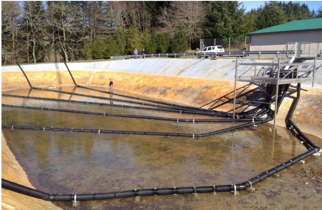
Figure 11 : Mise en eau du système de lit de boues à Augères (mars 2017)
