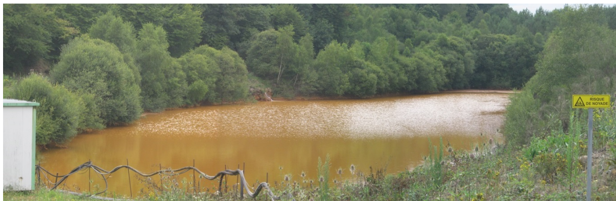
Figure 3 : Bassin de réception B 18 000 du site de l'Ecarpière (44 - 49)
