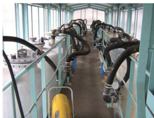
Station de Lodève avec les conteneurs de résine
