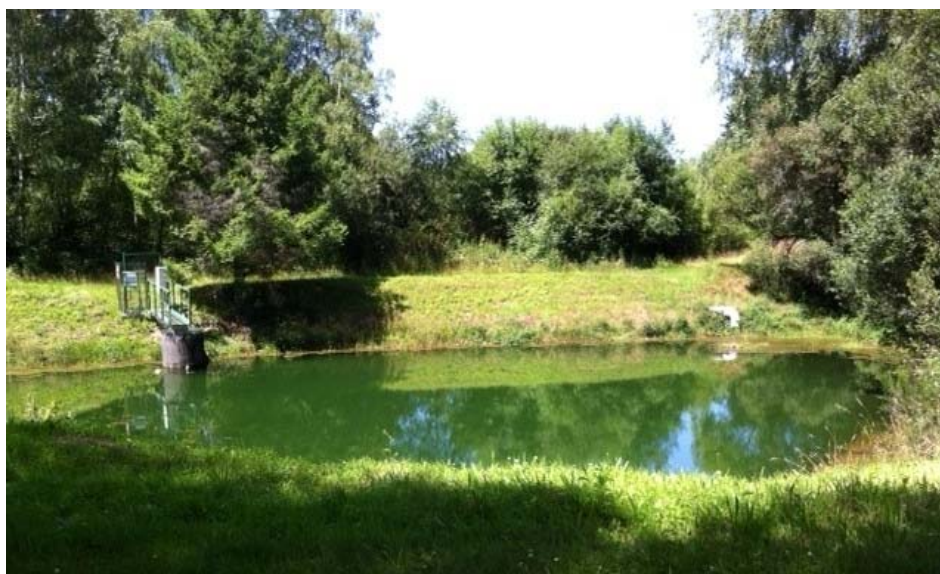
Figure 32 : Bassin de collecte de la station de traitement des eaux de Silord (87)
