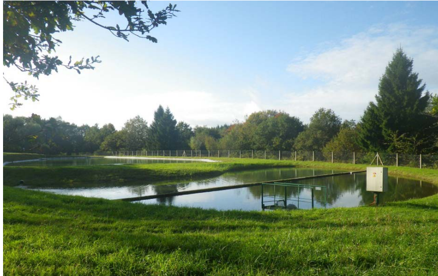
Figure 26 : Bassins de décantation de la station de traitement des eaux du Fraise (87)
