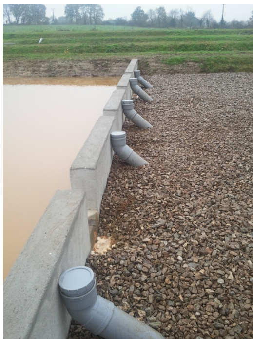
Figure 7 : Séparation entre le bassin de pré-décantation et le drain calcaire dans la stalle n°1, station de traitement des eaux de Beurepaire (85) (Schick, 2015)
