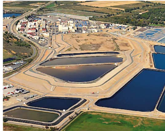
Vue aérienne du site Orano de Malvési
