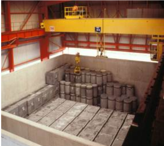
Manutention de colis en béton dans un ouvrage de stockage du centre de l'Aube
