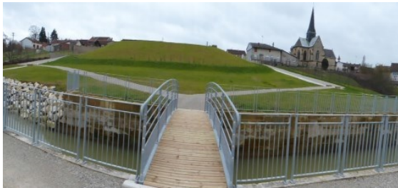
Vue du site Orflam-Plast après les travaux de réhabilitation.
