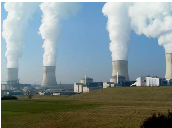
La centrale nucléaire de Cattenom
